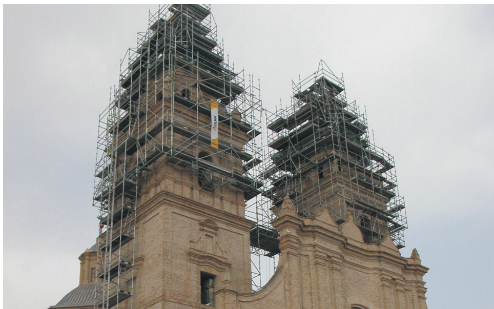
Imagen de las torres en pleno proceso de restauración
